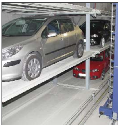
Instalación de Park-in
